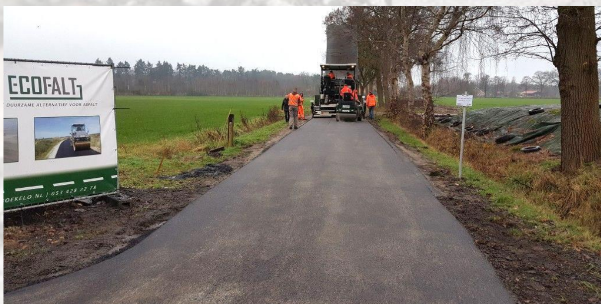
Aanleg teststuk Nieuwe Beekweg in Enschede
