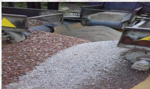
Het mengsel bestaat voor 90% uit gerecycled slooppuin
