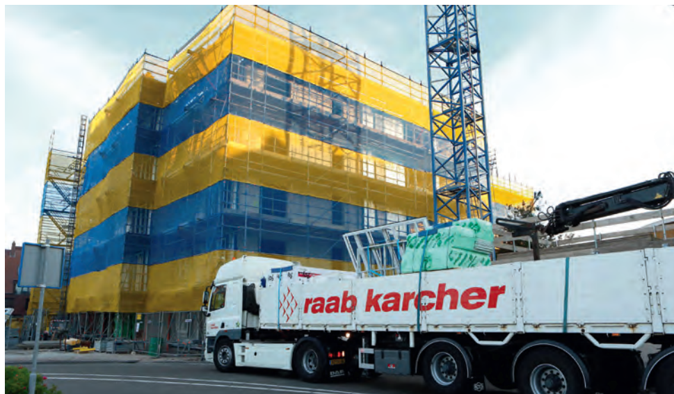
Vanuit de vrachtwagen wordt exact op hoogte geleverd. (Foto's: Raab Karcher)
