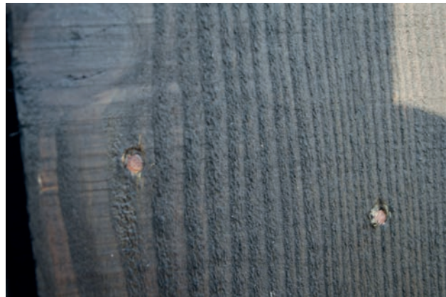
De koploze houten nagels worden niet op gelijke hoogte genaald vanwege slijptrisico van het hout.
