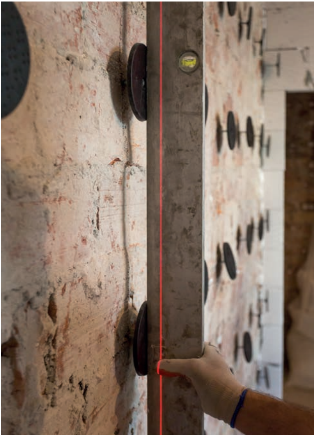
Via een laserpas de exacte hellingsgraad bepalen. "Ideaal voor scheve muren in een renovatiewerk."
