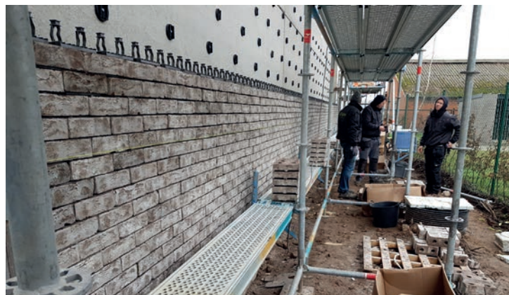
Voor het in elkaar klikken van een gevel zijn geen gekwalificeerde metselaars nodig.
