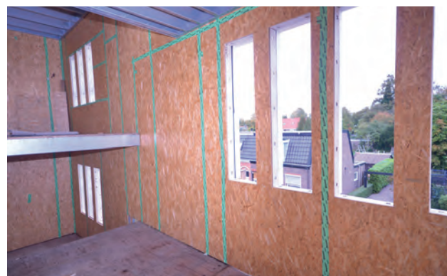
Aan de binnenzijde van de gevel worden OSB 4-platen op de kolommen en de profielen gemonteerd en afgeplakt.
