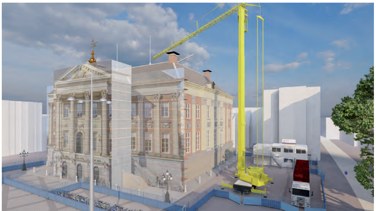
Bouwplaats van verbouwing stadhuis Groningen haarfijn in 3D gemodelleerd.
