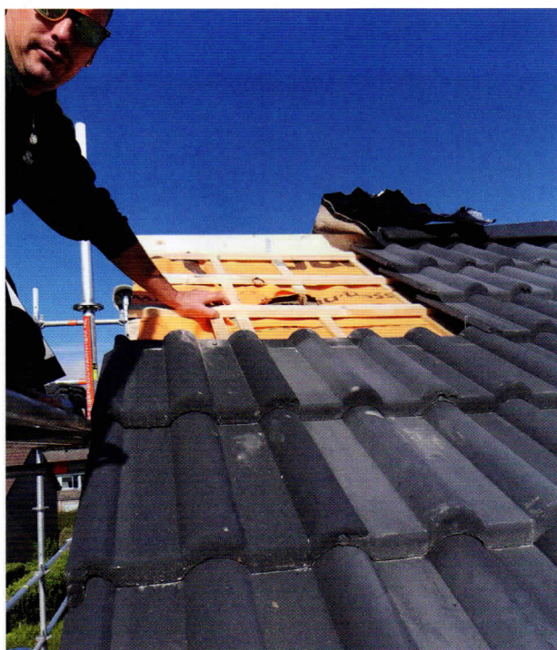
Foto links Vervanging van het tengelwerk.
