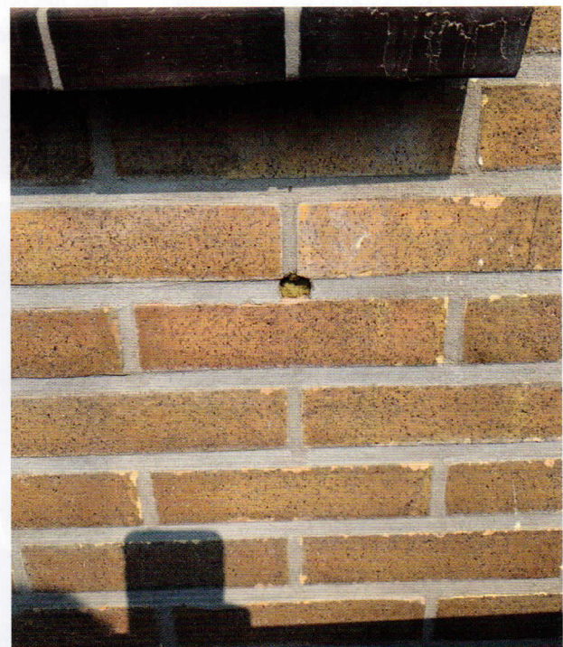
Foto rechts De spouw is na-geïsoleerd tot een R_c -waarde van 1,8.
