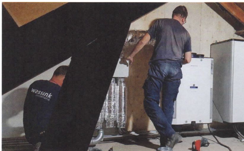
Wassink Installatie bezig met de installatie van de warmtepomp.
