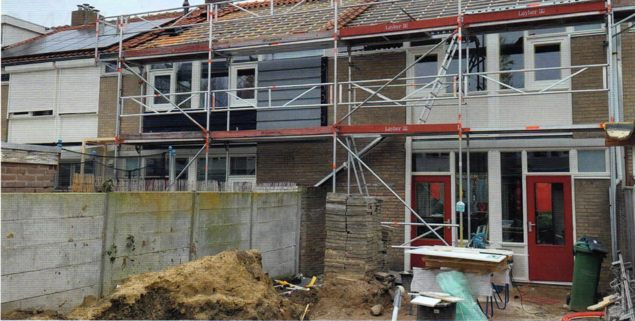
Woning in de steigers met het grijze warmte-wingevpaneel. (Foto: Emergo)
