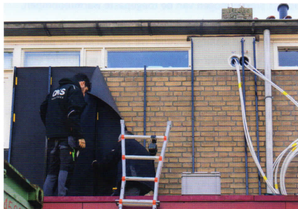
Toepassing van de warmtewingeveld vereist een goede isolatie. (Foto: Emergo)
