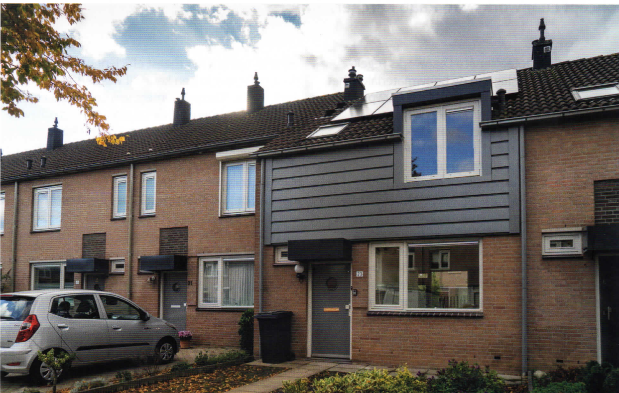
Slechts een oppervlakte van 15 m 2 warmte-wingev is al voldoende voor een energieopbrengst van 45 GJ. (Foto: Emergo)
