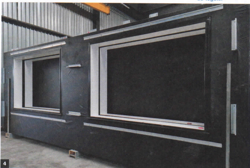
4 De binnenspouwbladen worden compleet voorzien van folie en een ophangstelsel voor de tegels.
