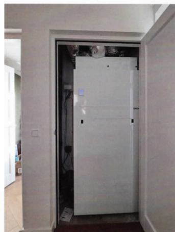
De compacte warmtepomp van Nilan met geïntegreerde componenten is geschikt voor kleine ruimten.
