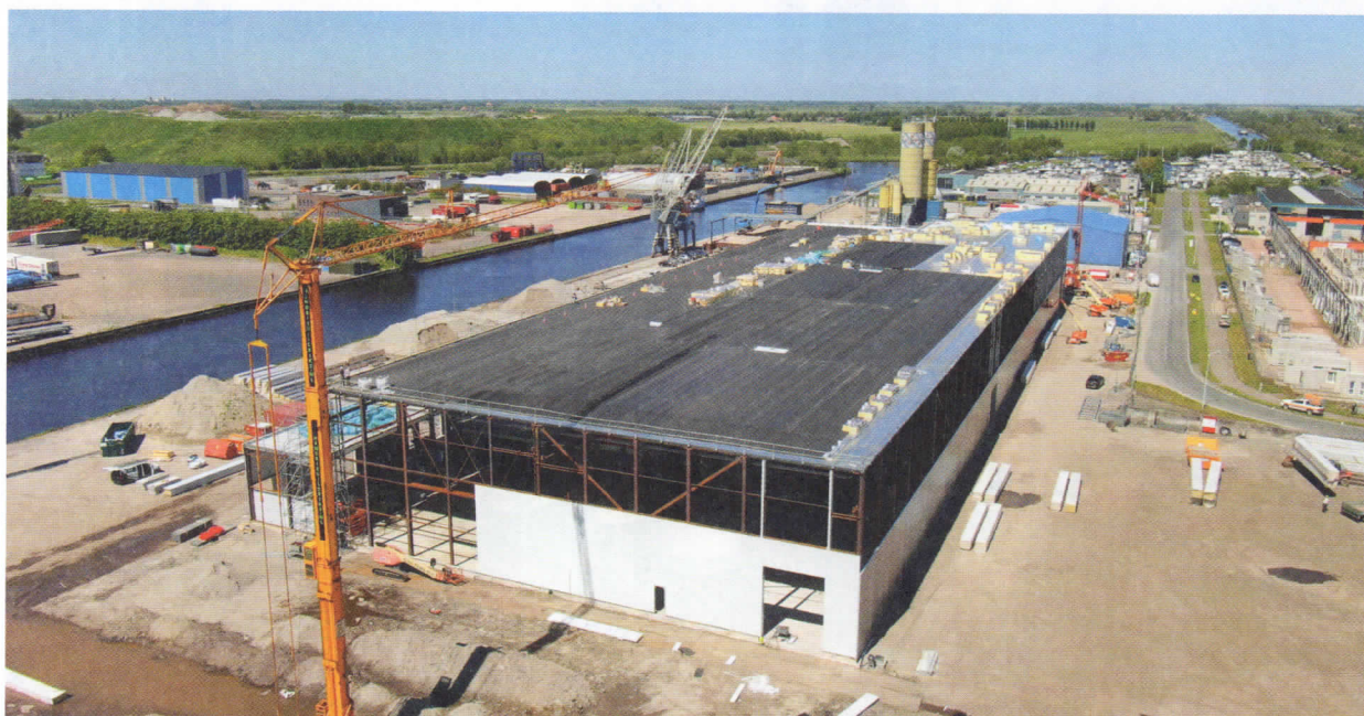
Inductiebevestigd dak op nieuwe woningfabriek van Van Wijnen. (Foto: CCM)
