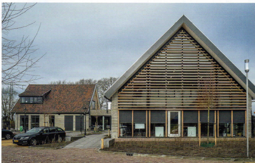
Het eindresultaat van de circulaire nieuwbouw van bedrijfspand De Boerderij.
