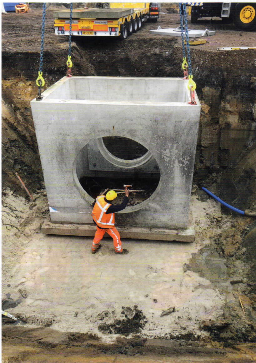
Plaatsing van een herbruikbare waterbergingsput van Twentemilieu Hengelo.
