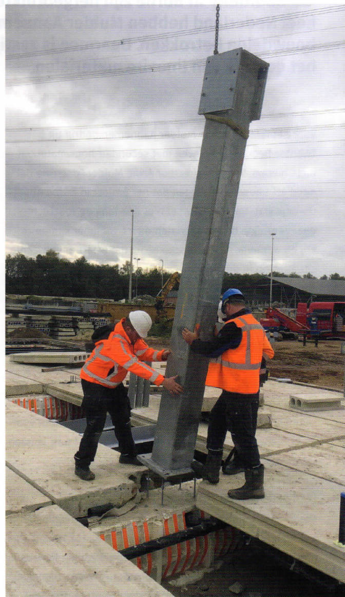
Stalen kolommen: net als de kanaalplaten geogost uit MC Erasmus in Rotterdam
