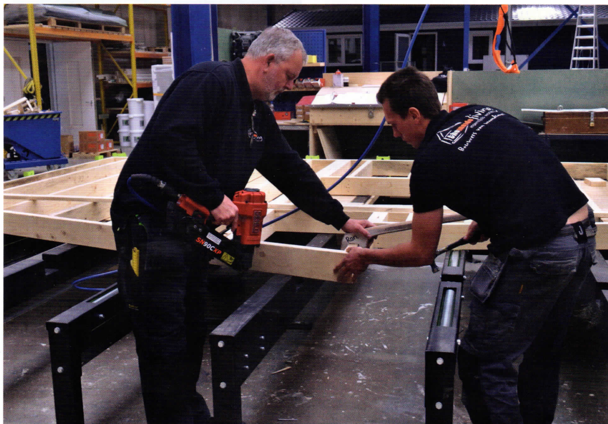
Op de assemblagetafel wordt het frame gemonteerd.
