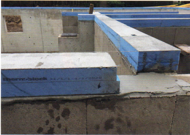
De thermoblokken tussen de kelder en de bovenbouw voorkomen koudebruggen.
