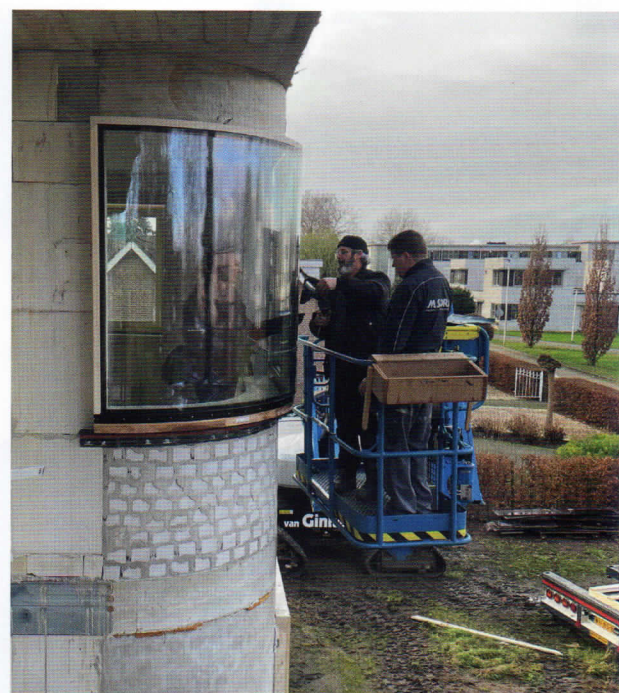
Het Passiefhuis Premium wordt voorzien van gebogen triple glas met een U-waarde van 0,5.
