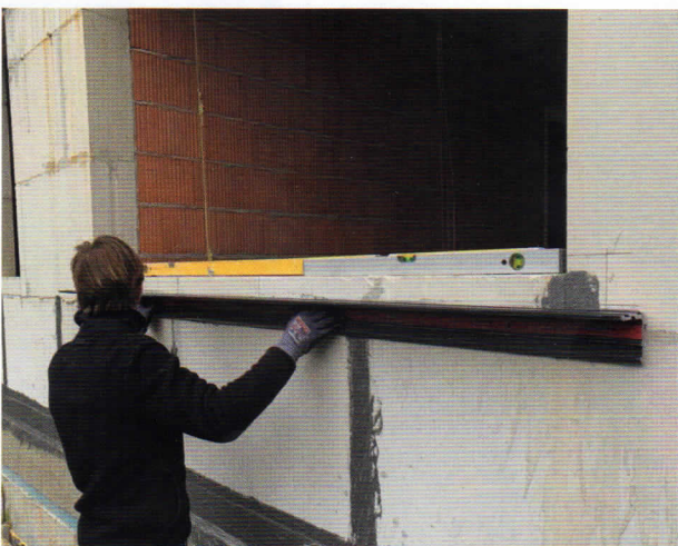
Glasvezelversterkte L-vormige elementen van Soudal zorgen voor de ondersteuning van de kozijnen, waardoor er géén stalen profielen nodig zijn. Voor een thermisch optimale kozijninstallatie zonder koudebruggen.
