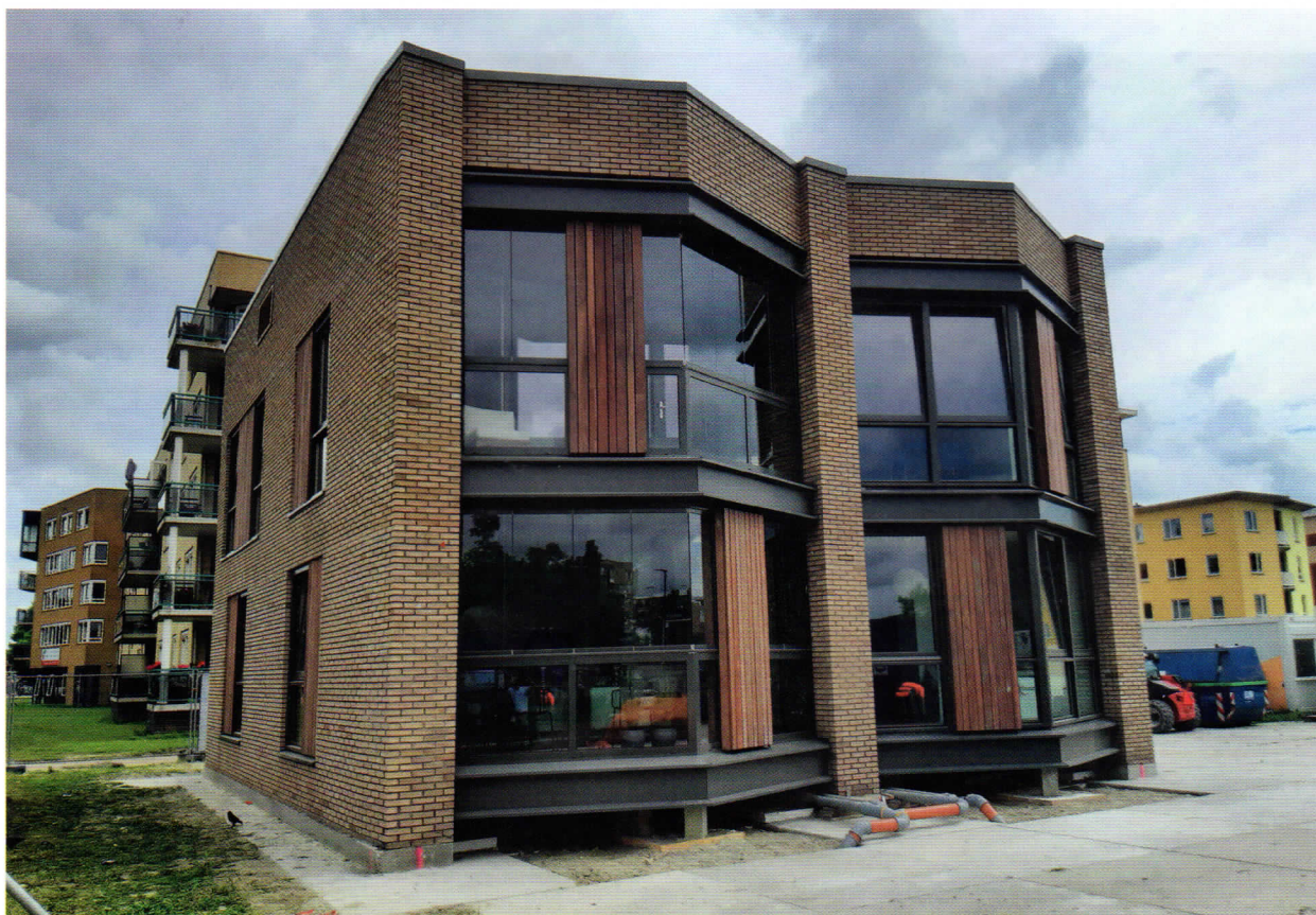
De mock-up van de modelwoning met geknikte opgemetselde buitengevel en azobé delen.
