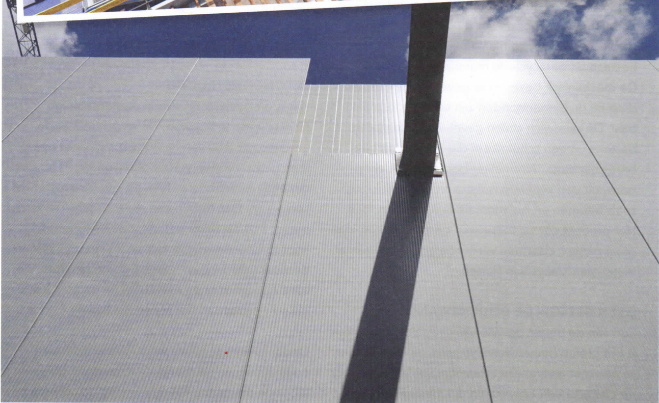
Gevens en dak worden bekleed met stalen sandwichpanelen.
