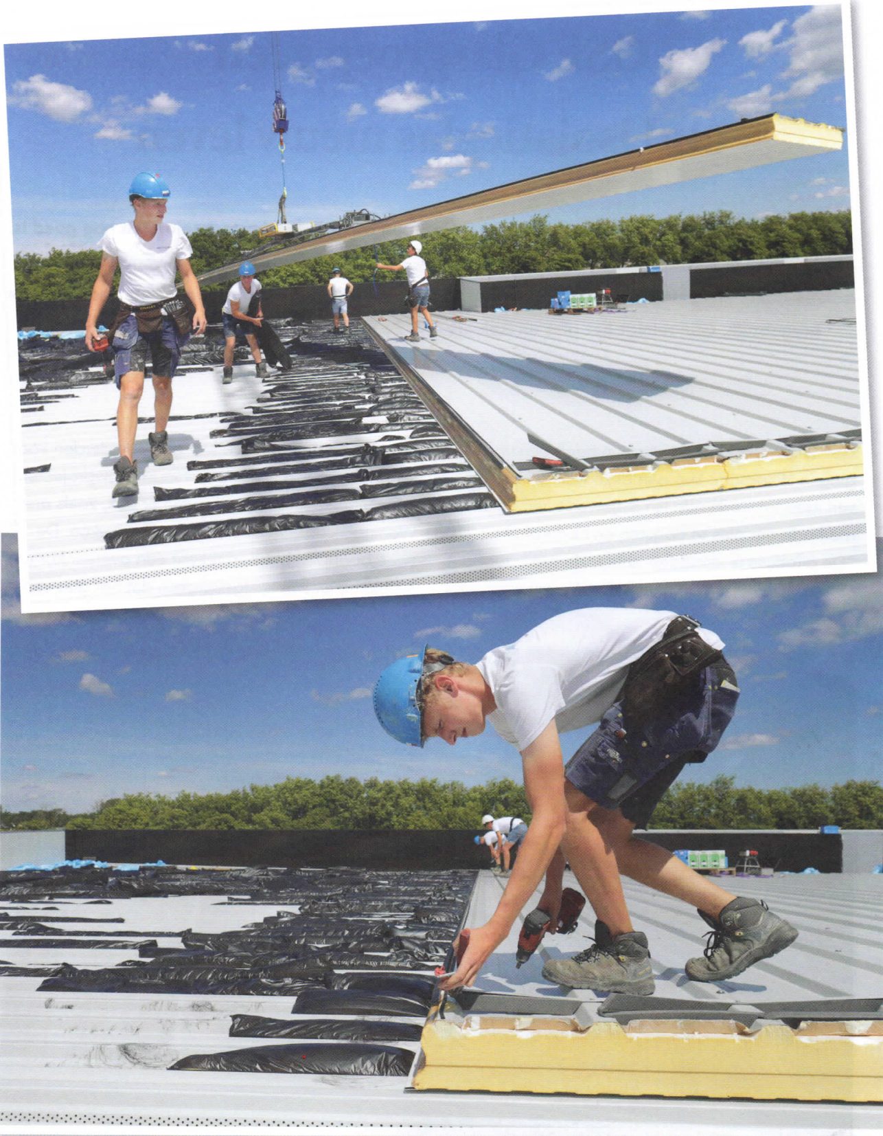
De gevel- en dakpanelen hebben een schuimkern, die bestaat uit herbruikbaar hars.
