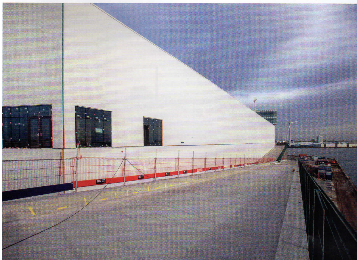
De hellingbanen ontsluiten het wegverkeer van de cityhub.
