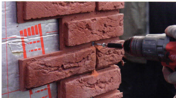
De panelen worden altijd op de isolatie geschroefd.
