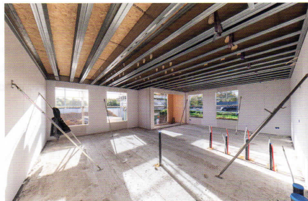
Met staalframebouw is een grote vrije overspanning mogelijk.
