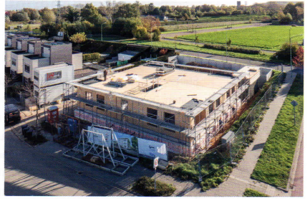
Bovenaanzicht van Woonvilla in aanbouw.
