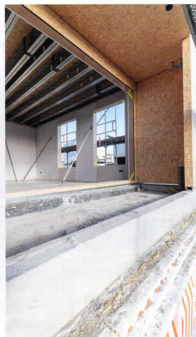
Met staalframebouw is een grote vrije overspanning mogelijk.
