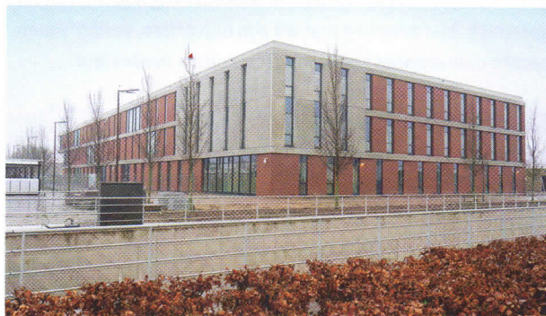
Het nieuwe poliklinisch centrum Rijnstate is het eerste ziekenhuis in Nederland dat waterstofenergie opwekt, opslaat en gebruikt.
