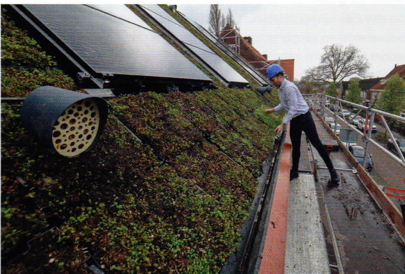
Alle toegepaste elementen zijn demontabel. Het aluminium zetwerk rondom het dak is modulair toepasbaar en kan in- en uitgeschoven worden.
