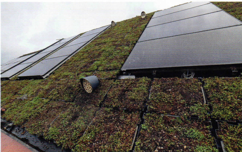
Onder het groendak liggen HDPE-elementen die tevens dienen als waterkering. Op deze modules ligt een framework waarop de plantentrays worden ingehaakt en gefixeerd met ankers. De HDPE-plantenbakken zijn gemaakt van een biobased grondstof.
