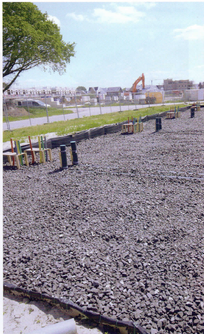
Onder de betonvloer komt een fundering van glasschuim.
