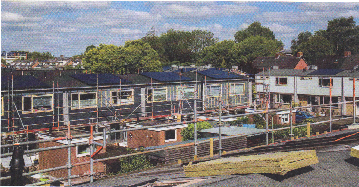
Isolatieverbetering is altijd een eerste vereiste bij een duurzame woningrenovatie. (Foto: Plegt-Vos)
