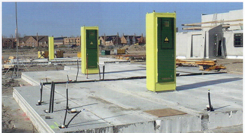
Aansluiting op het net kan in de ruwbouwfase al plaatsvinden door toepassing van de prefab meterkast. (Foto: Bouwend Nederland)
