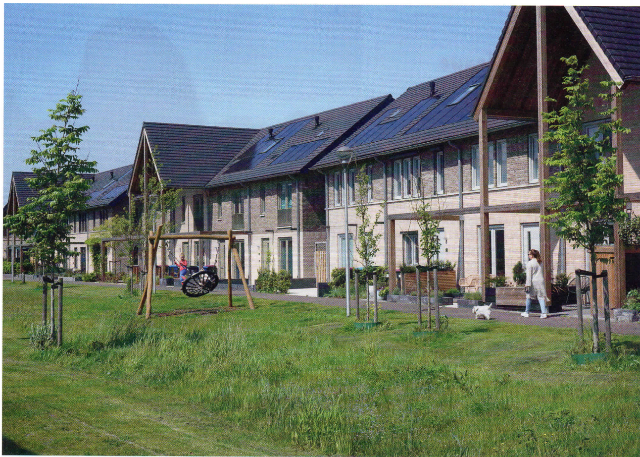
Volgens Sluijsman moet elk stedenbouwkundig plangebied het hemelwater volledig kunnen verwerken. (foto Heijmans)
