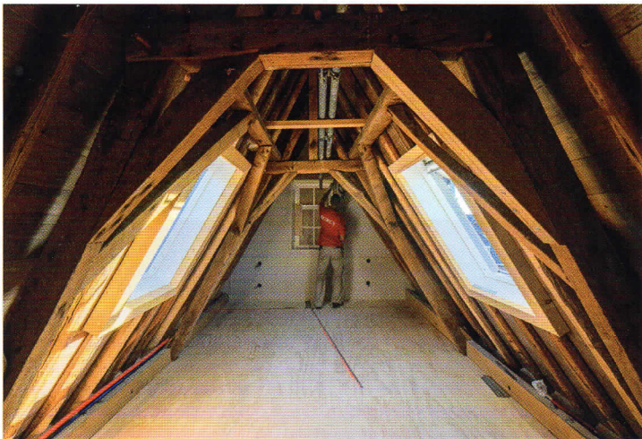
In de 17e-eeuwse kapconstructie zijn aan weerszijden twee dakramen ingebouwd.
