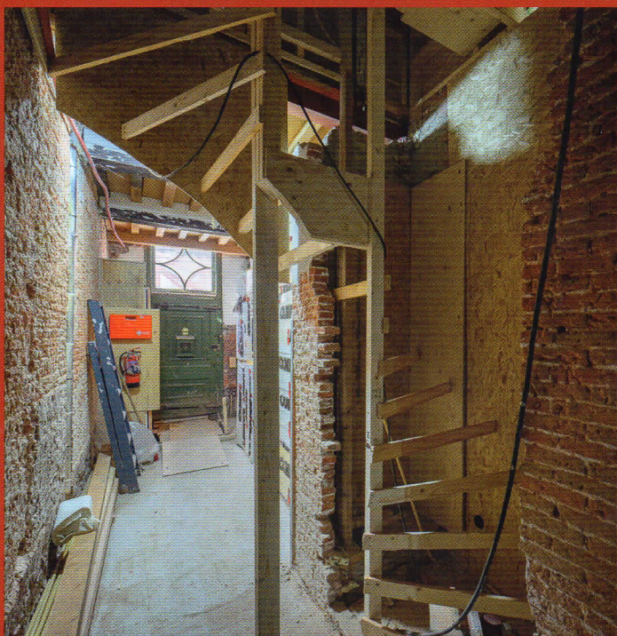
De nieuwe spiltrap vanaf de begane grond moest aansluiten op de zoldertrap.
