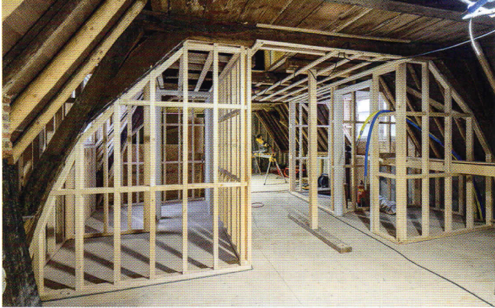
Er kwam veel timmerwerk kijken bij de opbouw van hsb-binnenwanden.
