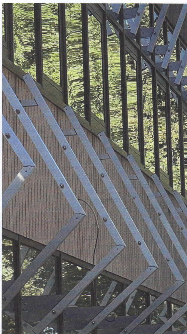
Onder: Metadecor heeft de achterconstructie van de lamellen verder geëngineerd (foto: BCT Architecten).
