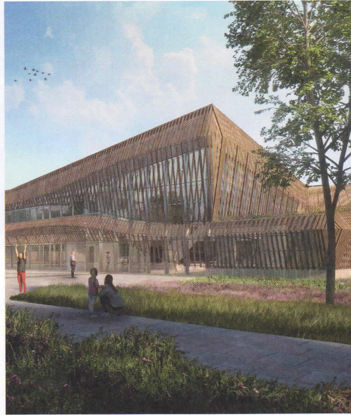
Geen enkel profiel van de achterconstructie is hetzelfde (impressie: Architech Company).
