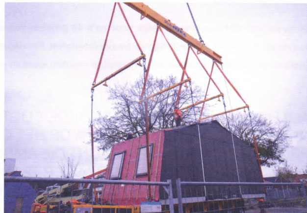
Op afroep takelt een enorme telescoopkraan met de evenaar de module op een oplegger. Een operator bedient het gevaarte met een joystick en loodst hem door de nauwe straten van Zaandam naar de plek van bestemming. In totaal worden er 95 modulaire woningen gerealiseerd in de Rosmolenwijk.
