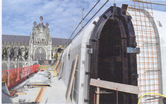
Boven: aan de bouwhoogte van het theatergebouw mocht niet worden getornd.
