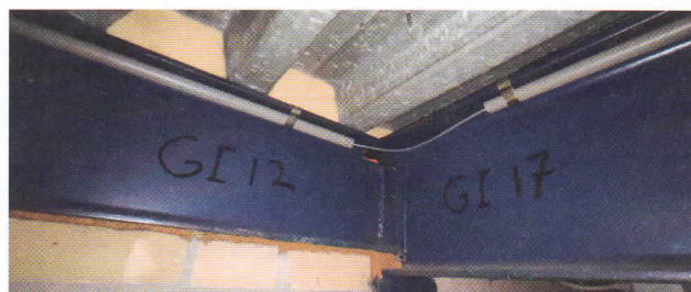
Onder: nummering van de profielen is handig in verband met de montage (foto: IMd Raadgevende Ingenieurs).
